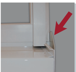
Bild 2 Abdeckung des Gewerkelochs mit dem bewa-plast Entwässerungsmodul.
